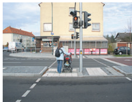
Bild 5: Getrennte Querungsstelle mit LSA, Randeinfassung errichtet mit konventionellen Bordsteinen (Fulda, 2007)
