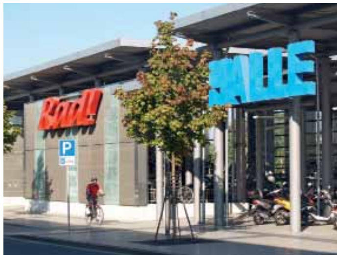
Die Radwege in Richtung Bahnhof enden direkt am Fahrradparkhaus, von dem es nur wenige Schritte zu den Bahnsteigen sind.
