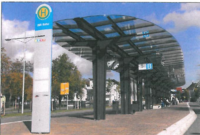
Der Mittelbussteig ist mit Kasseler Sonderbord und einer gläsernen Überdachung ausgestattet. Die Fahrgastinformation entspricht dem Standard im Heilbronner Verkehrsverbund.
