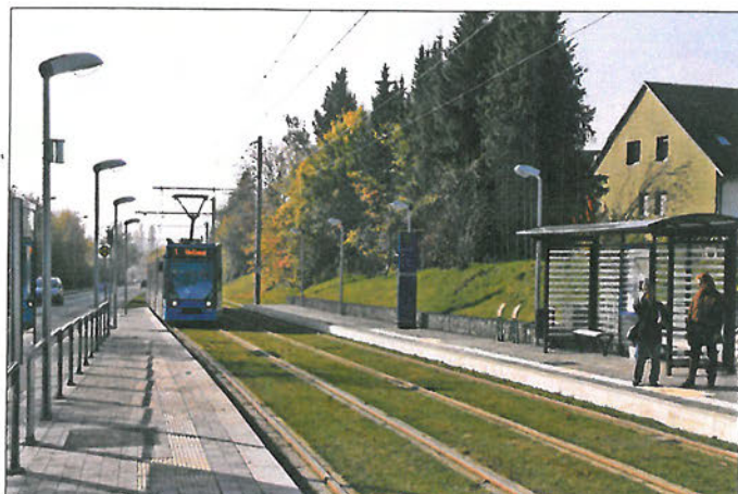
Haltestelle Musikerviertel in Blickrichtung Stadtmitte – die Infrastruktur der Straßenbahn fügt sich bestens in das Umfeld ein und macht schon am ersten Betriebstag den Eindruck, als ob sie schon immer dagewesen wäre.
