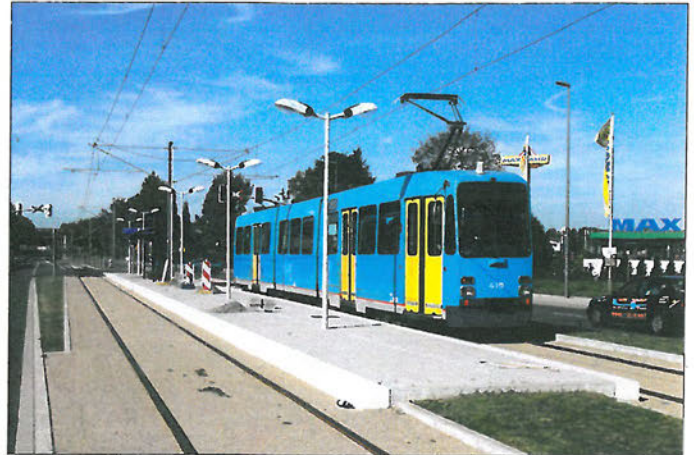
Haltestelle Berliner Straße im Linksfahrabschnitt mit Mittelbahnsteig und Wagen in Fahrtrichtung Innenstadt
