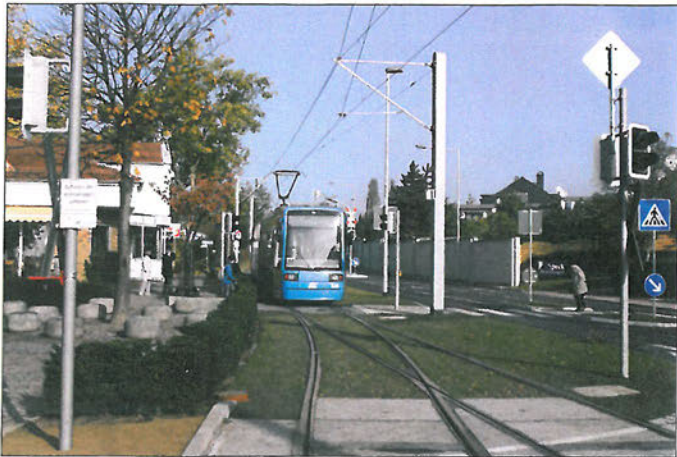
An die Haltestelle Stadtmitte schließt sich in Richtung Vellmar-Nord ein kurzer eingleisiger Abschnitt an; hier wäre nur mit Eingriffen in das Umfeld ein zweites Gleis machbar gewesen
