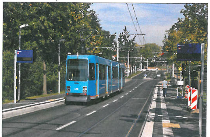
Haltestelle Festplatz, Blickrichtung Stadtmitte; erkennbar die Integration der Haltebereiche in die Gehwege, über die auch der Fahrradverkehr geleitet wird.
