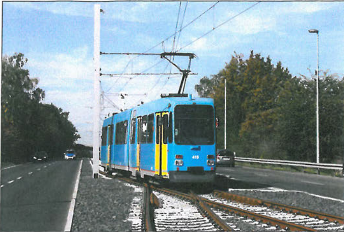
Kurz vor der Haltestelle Triftstraße wird im Mittelstreifen der B7 in Fahrtrichtung Kassel in den Linksfahrmodus gewechselt.
