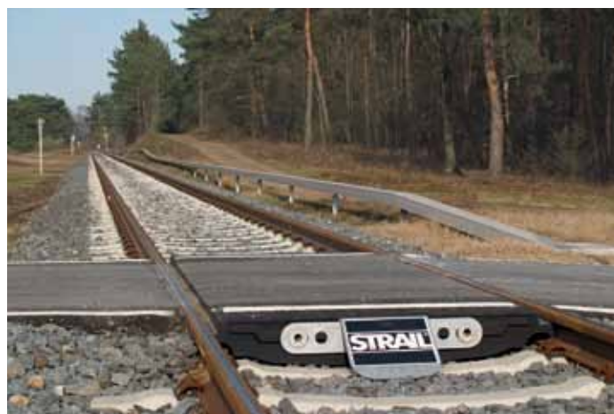
Links: Modernste Sicherheitstechnik von Scheidt & Bachmann kennzeichnet den Bahnübergang Eberstädter Straße kurz vor der Endstation. Rechts oben: Orientierung bietet die Infosäule, die auch mit einer Sprechstelle zur DADINA-Fahrgastinformation ausgestattet ist. Rechts unten: Die technisch ungesicherten Übergänge an der Strecke erhielten innoSTRAIL-Bahnübergangsplatten mit schmaler Spurrinne.
