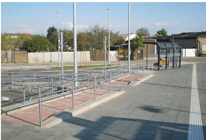
Oben: Am 6. Mai 2013 hat VT 650.86 den neuen Haltepunkt Inselstadt Malchow erreicht. Im Hintergrund das Einfahrsignal des alten Bahnhofs. Unten: Ein taktiler Blindenleitsystem führt zum Bussteig, der mit dem Kasseler Sonderbord des Herstellers Profilbeton ausgestattet ist.
