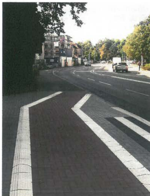
Bild 2: Städteplanern, Handwerkern, Straßenbauern und kommunalen Entscheidern soll die einfache Realisierung parallel geführter Rad-Gehwege nach DIN 32984 ermöglicht werden
