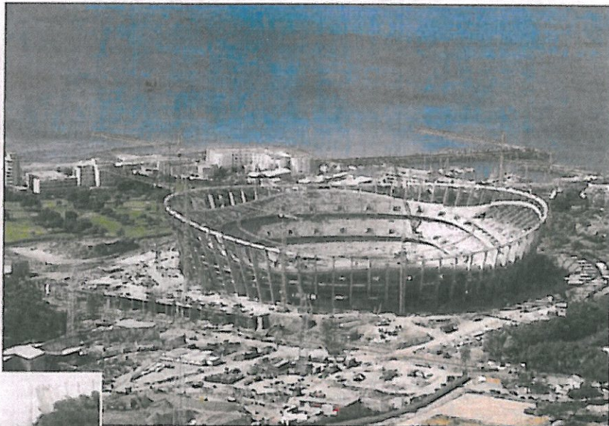
Imposant: Der Umbau des Stadions Athlone am Kap der Guten Hoffnung. Überall wird in Kapstadt für die Fußball-WM im kommenden Jahr gebaut. Fotos: privat
